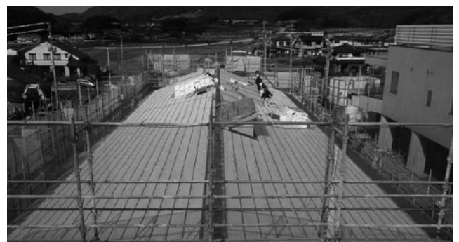
グループホーム屋根工事
