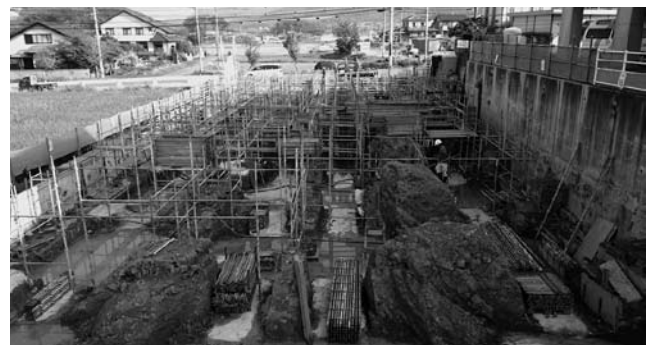
グループホーム1階部分基礎工事
